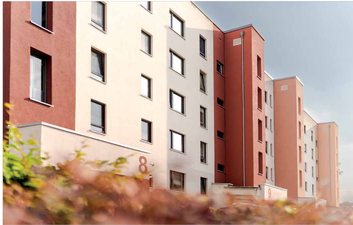
Barrierefrei bis in die oberste Etage: Aufzugsschächte am Platz der Einheit 8–11 in Grimma-Süd III. Foto: David Rieger Redok Art
