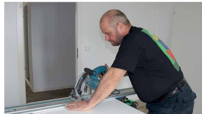
Holger Leuthold schneidet in einer Wohnung im Neschwitzweg eine Tür zu. Beide Fotos: Frank Prenzel
