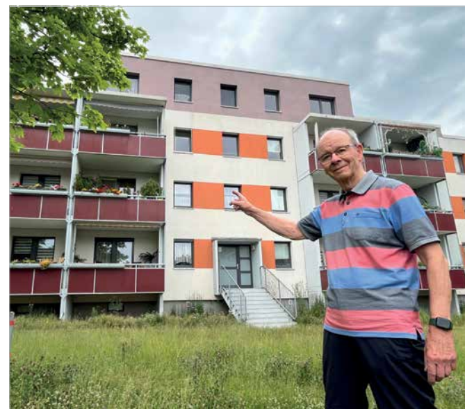
Längst ein schickes Wohnhaus: An der Holzecke 1–3, doch bei der Bau- abnahme des zum Ende der DDR errichteten Blocks entdeckte Frank Streller als damaliger Technik-Leiter der Genossenschaft massive Män- gel, auch an den Balkonen. Foto: Frank Prenzel
