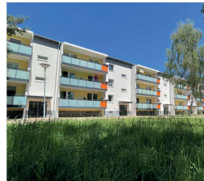
Um zwei Geschosse geschrumpft und familienfreundlich umgebaut: Südstraße 37–43 in Grimma-Süd II.
