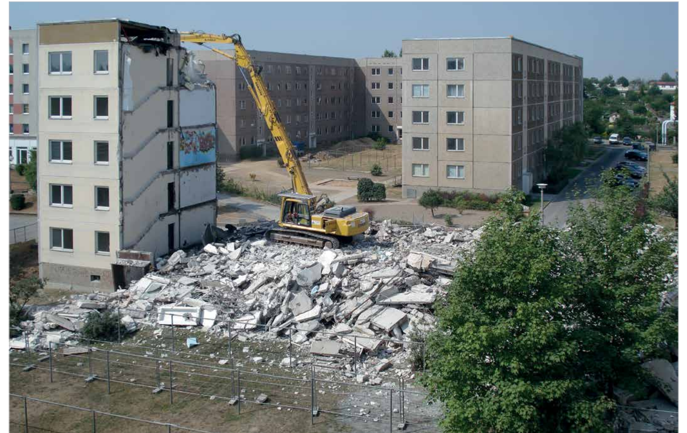
In Grimma-Süd III fraß sich 2006 der Abrissbagger durch genossenschaftliche Platten.
