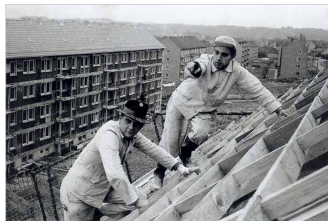
Dacharbeiten in der Straße der Jugend.
