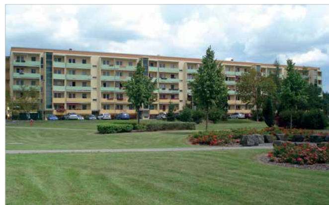
Hingucker: in der Südstraße 1–15 wurden die Außenaufzüge in die Balkonanlage integriert.
