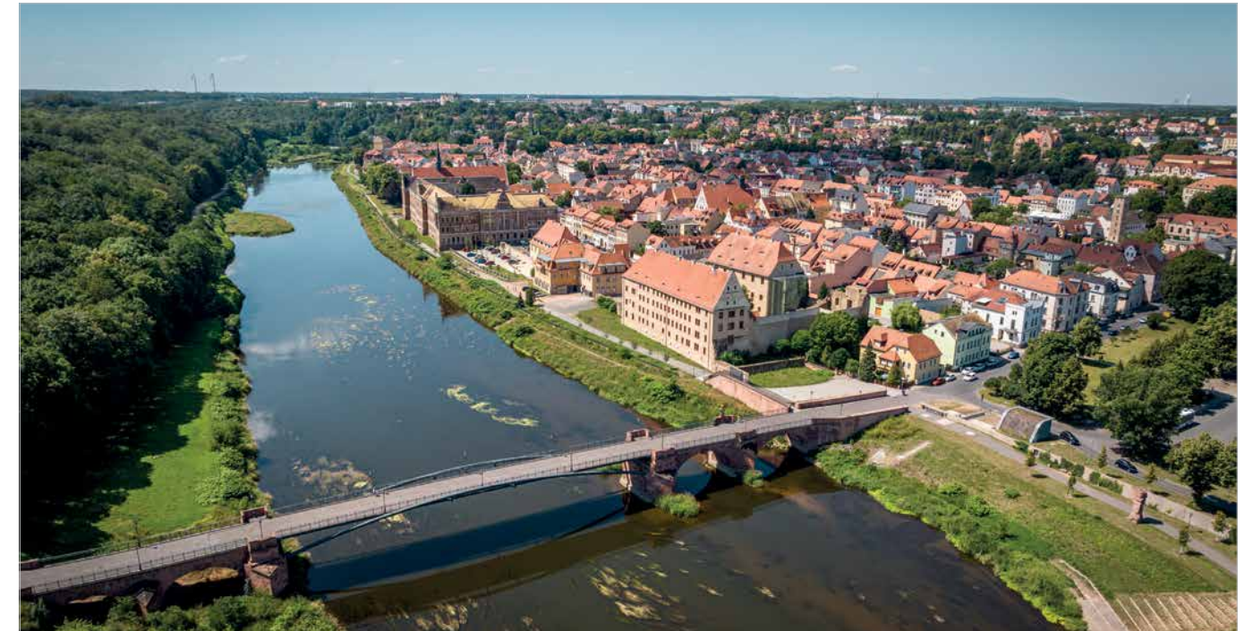
Stadtansicht Grimma mit Pöppelmannbrücke im Vordergrund. Foto: PhilippHerfortPhotography
