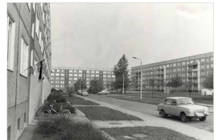
... und nach Fertigstellung.
