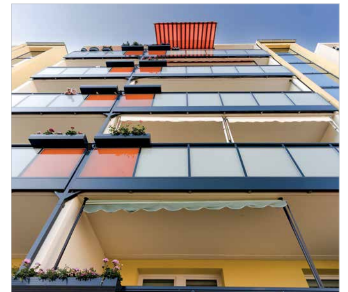
Neue Balkone und Außenaufzüge in der Südstraße 45–59 in Grimma-Süd II. Foto: David Rieger Redok Art
