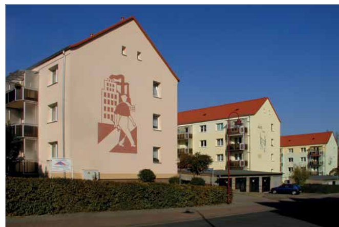
Am Wolfsgraben 16–32 neu.
